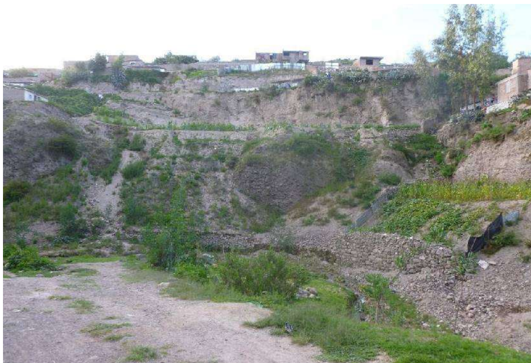
Fig. 13. Terrenos inconsistentes con sostenimientos artesanales en la Quebrada de Chaquihuaycco-Vista Alegre.
