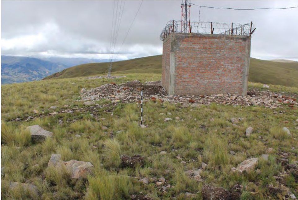
Fig. 28. Cimentaciones de viviendas circulares Huarpa, afectadas por la instalación de antenas internet (Claro)
