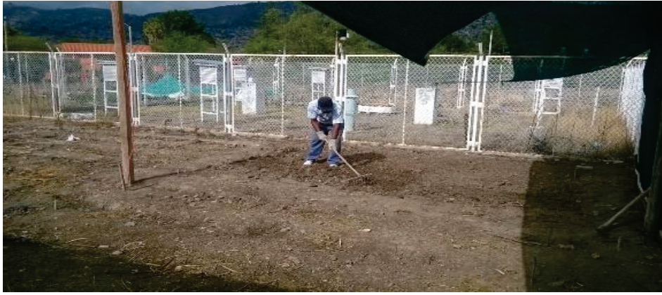
Fig. 4. Preparación de terreno
