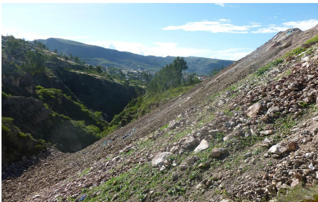
Fig. 17. Cauces rellenos de 80 a 90 metros de altura con materiales de desmonte en la quebrada de Ñahuinpuquio.
