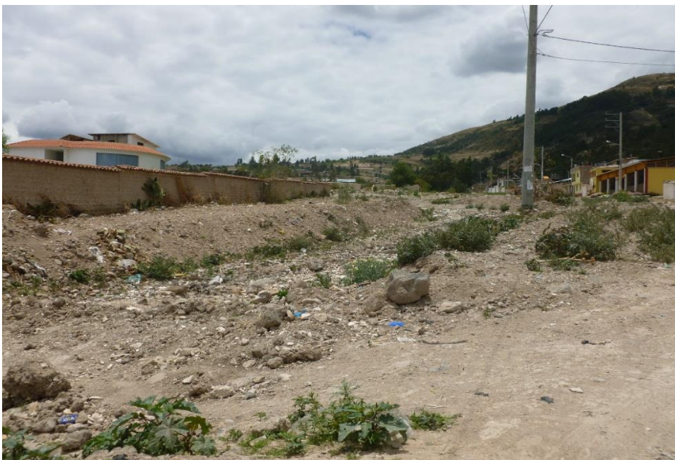
Fig. 11. Lecho inundada en la quebrada de Quicapata totalmente relleno con desmonte de construcción.
